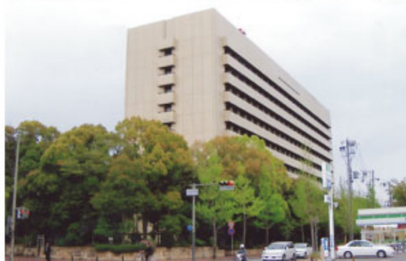
▲姫路市庁舎改修に着手
