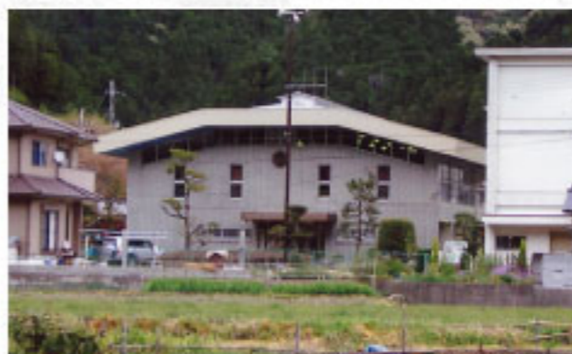
▲安富北小学校体育館 耐震補強工事 4,080万円
